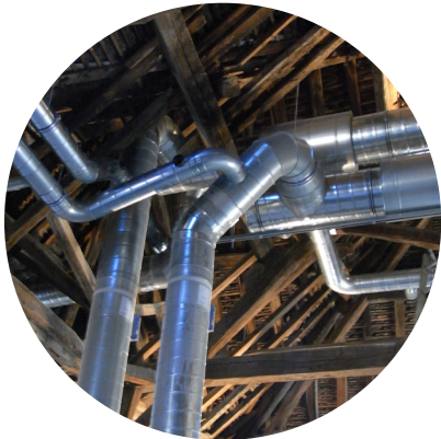
Installation des tuyaux de ventilation
