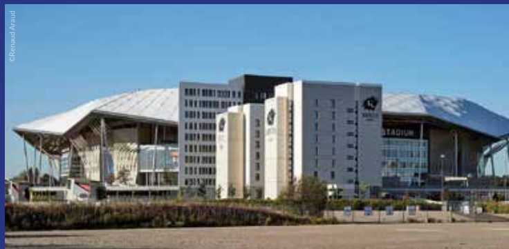
Le Kopster Hotel a été construit par em2c devant le Groupama Stadium de l'Olympique Lyonnais
