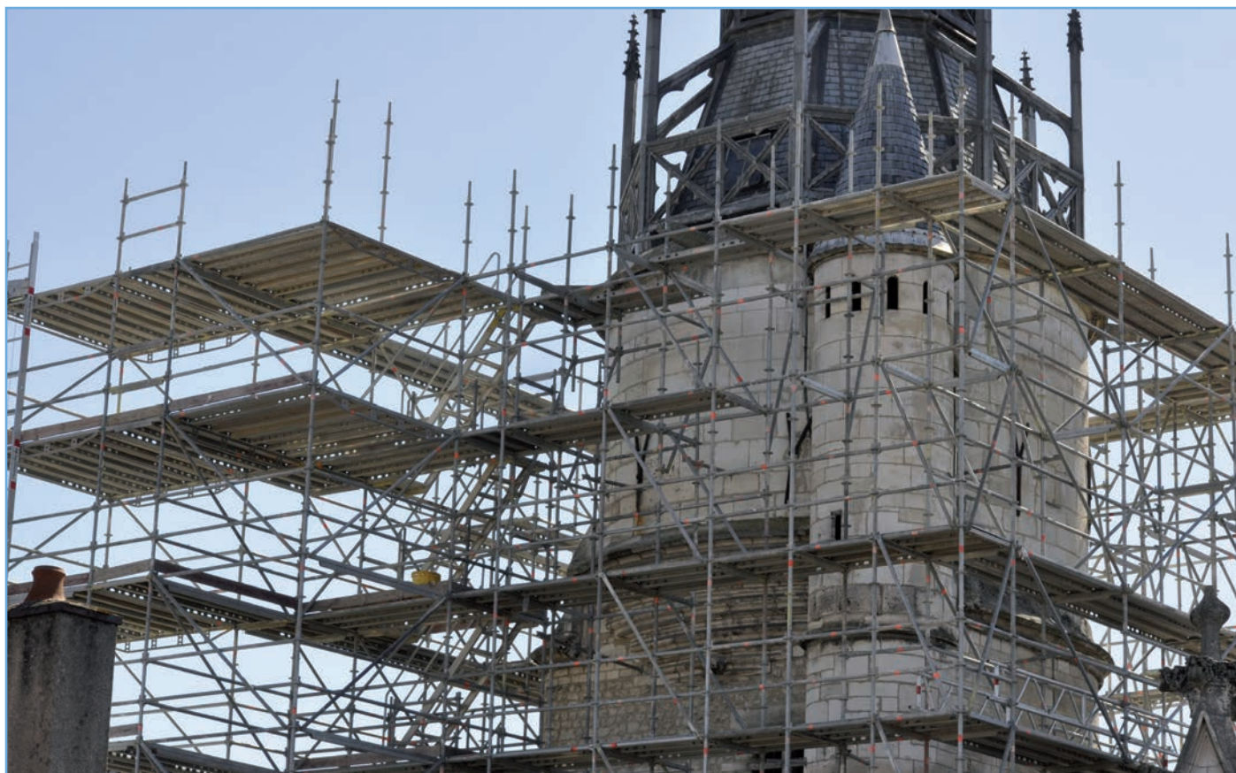
Chantier de la Tour de l'Horloge
