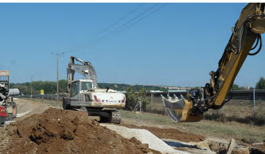
Profitant du beau temps les ouvriers ont pris un peu d'avance sur le calendrier. Les engins tracent les routes et creusent les galeries qui accueilleront les réseaux. Le compte à rebours est lancé pour que les premières entreprises puissent annoncer leur venue en 2019.
