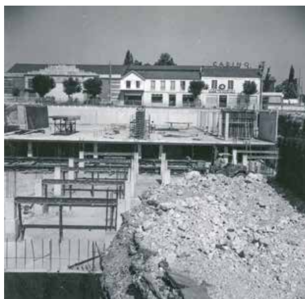
En 1973, lors des travaux de construction du futur marché et parking de l'Arquebuse, face à ce qui est aujourd'hui le cinéma CGR d'Auxerre.
