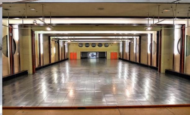
**Souvenez-vous :** Avec son plafond bas, la salle Vaulabelle offrait une acoustique désastreuse. La suppression du plancher des combles a permis de rendre apparente la charpente métallique et d'ouvrir une incroyable perspective valorisée par une hauteur de plafond digne d'une cathédrale moderne. Mais aussi d'offrir enfin, grâce à l'apposition de grandes plaques perforées sur les murs, une acoustique de qualité à la salle.
